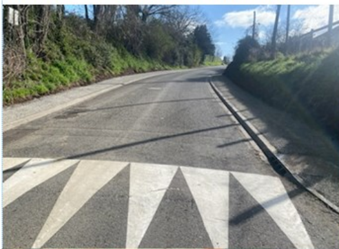
Réfection des trottoirs chemin du Tournier
