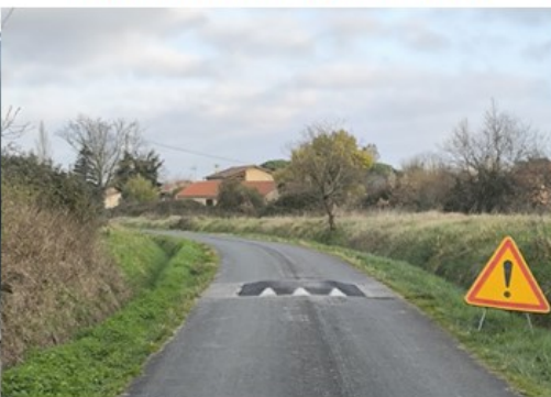
Installation d'un ralentisseur au Bouet
